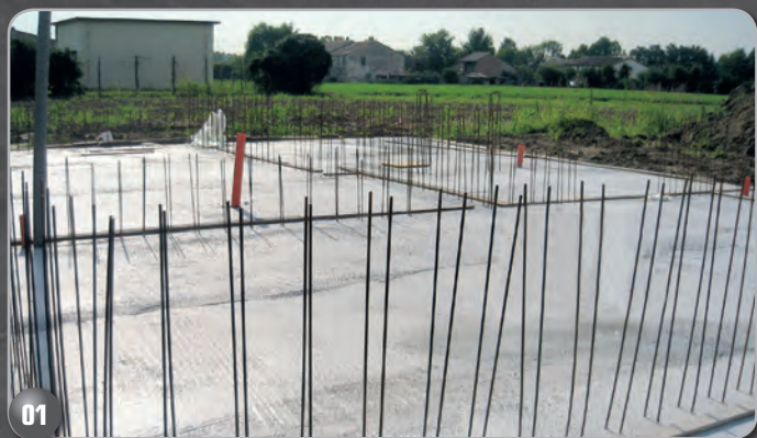
01 TRACCIAMENTO DELLE MURATURE
