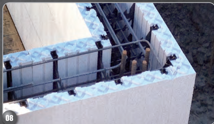
08 POSIZIONAMENTO DELLE ARMATURE NEGLI ANGOLI
