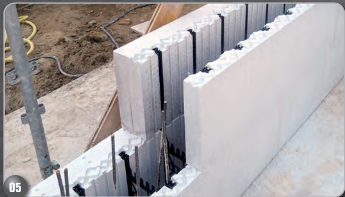
05 POSIZIONAMENTO DELLA SECONDA FILA DI CASSERI
