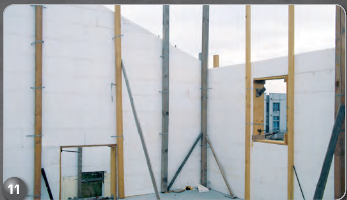
11 INSTALLAZIONE DEL SISTEMA DI ALLINEAMENTO
