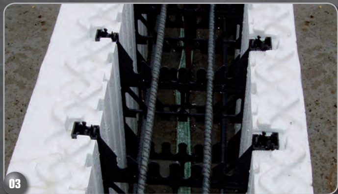
03 POSIZIONAMENTO DELLA PRIMA FILA DEI FERRI DI ARMATURA
