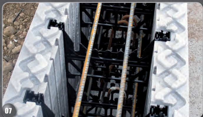
07 POSIZIONAMENTO DELLA SECONDA FILA DEI FERRI DI ARMATURA
