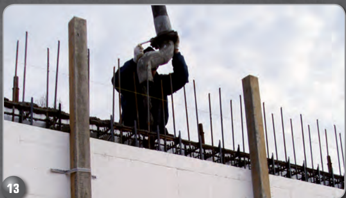
13 GETTO DEL CALCESTRUZZO
